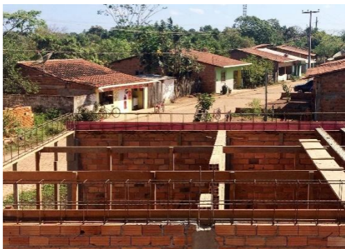
CONSTRUÇÕES DO ESTÚDIO NA COMUNIDADE DE BUBASA.
